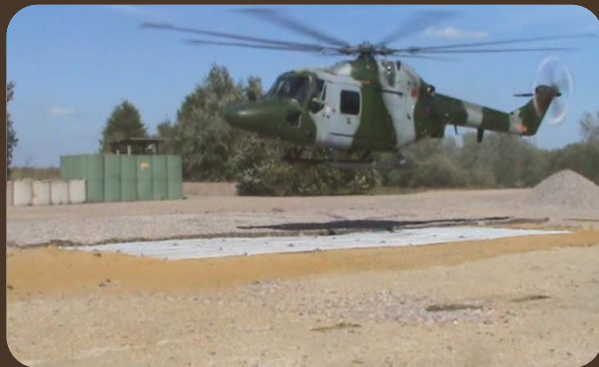
HELI-PADS / DUST SUPPRESSION
